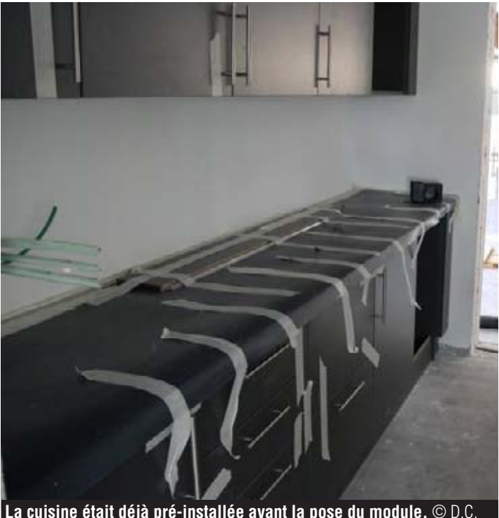
La cuisine était déjà pré-installée avant la pose du module. © D.C.
