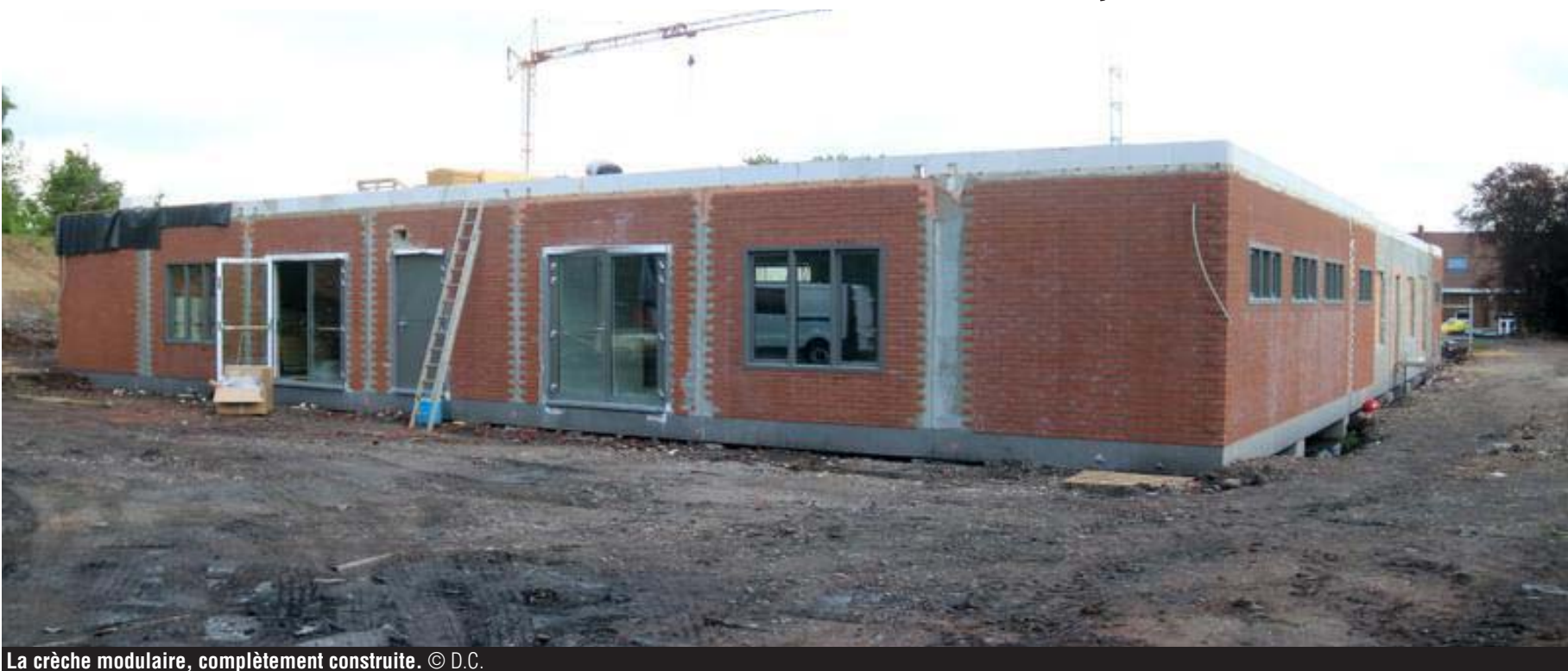
La crèche modulaire, complètement construite. © D.C.
