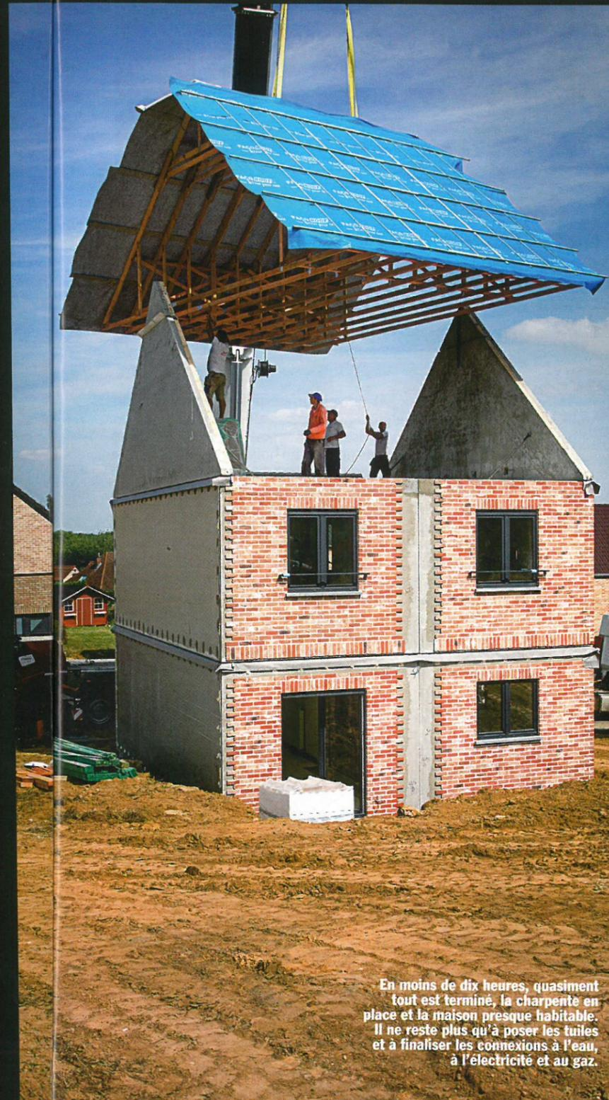
En moins de dix heures, quasiment tout est terminé, la charpente en place et la maison presque habitable. Il ne reste plus qu'à poser les tuiles et à finaliser les connexions à l'eau, à l'électricité et au gaz.
